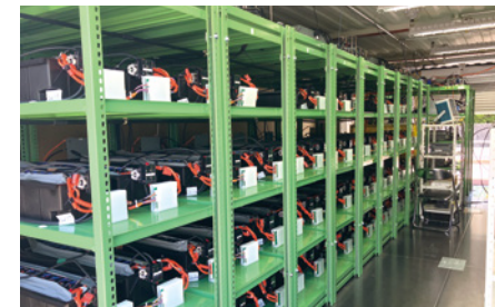
電動車用バッテリーを使用した大容量スweep蓄電システム
